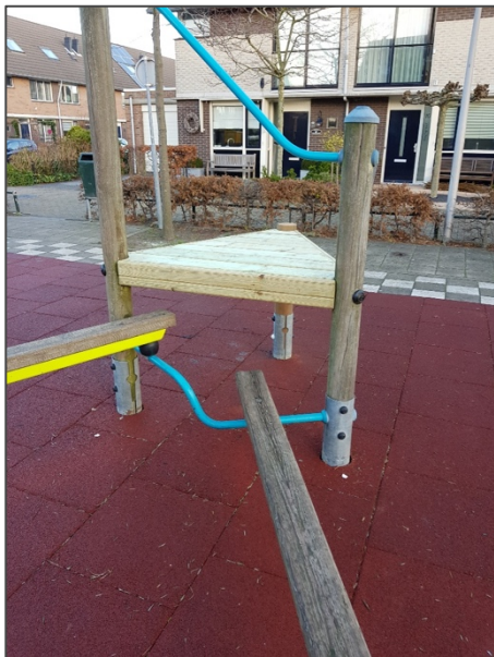
Figuur 3 Vervangen van het houten bordes
