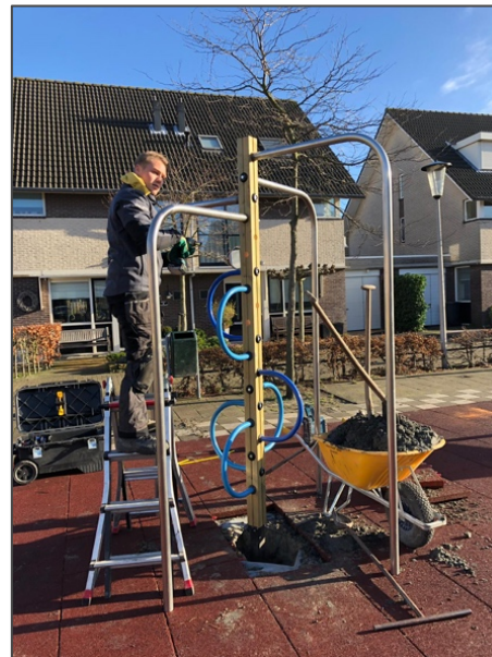
Figuur 2 Vervangen van de staander met toestel eigen materiaal
